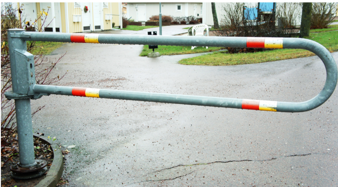
Bom som kan låsas upp med brandkårsnyckel. Foto: MSB
