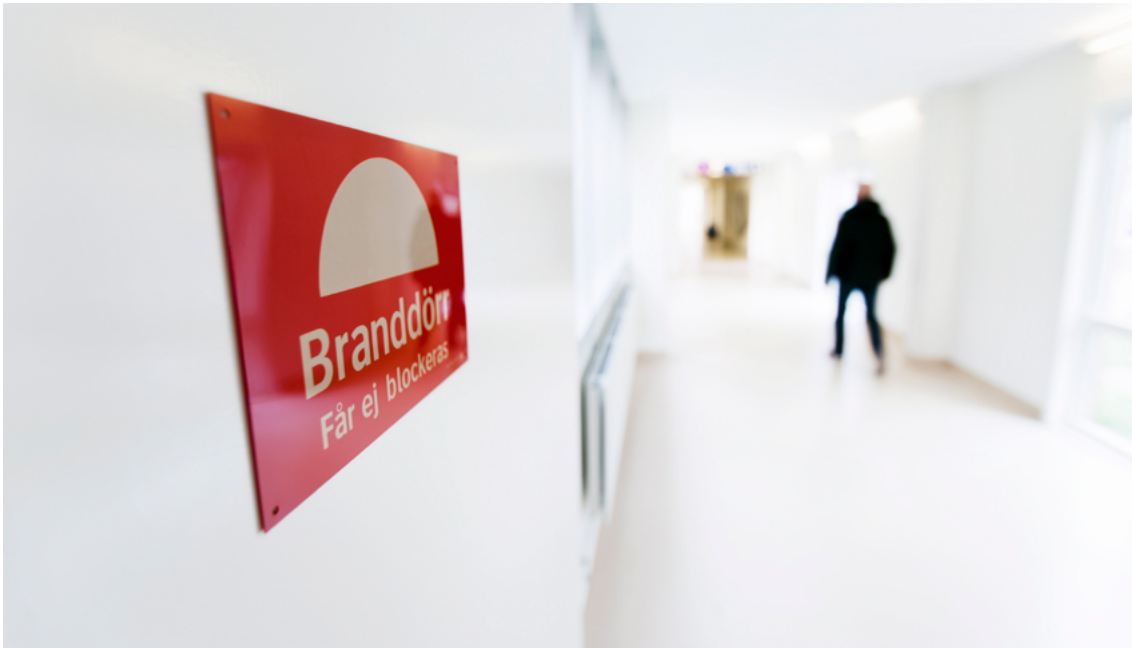
Det är viktigt att branddörrar hålls stängda. De får inte ställas upp med kilar eller dylikt. Foto: Johan Eklund
